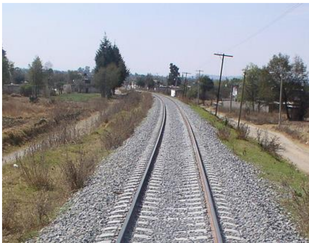
FERROSUR. Cambio de riel de 100 lb/yd a 115 lb/yd en toda la vía principal.
