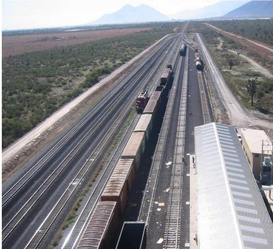
FERROMEX. Nuevo patio Monterrey
