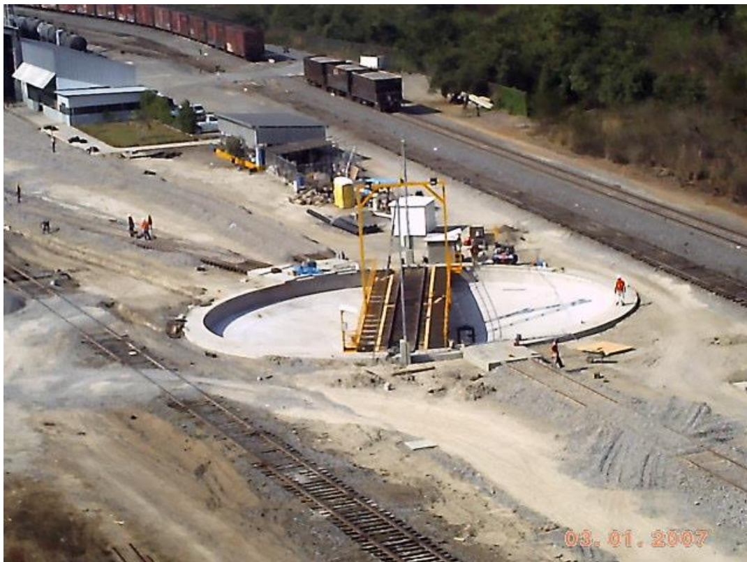
FERROSUR. Construcción mesa giratoria Tierra Blanca, Ver.
