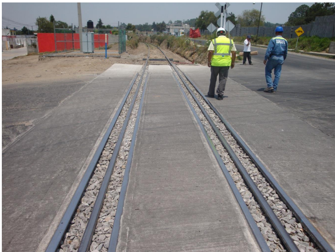
FERROSUR. Rehabilitación de cruceros a nivel.
