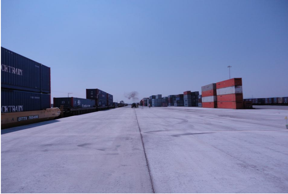
KCSM. Puerta México en Toluca, Estado de México.
