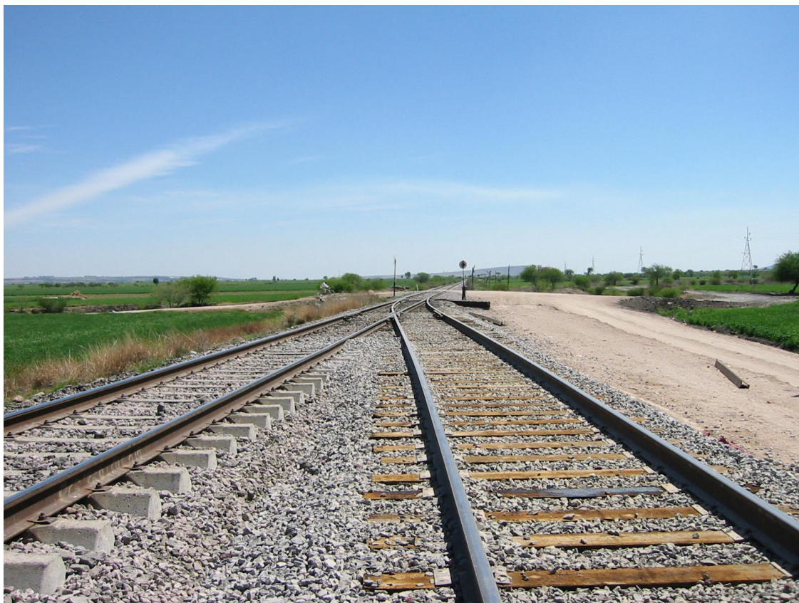
FERROMEX. Ampliación ladero Villalobos
