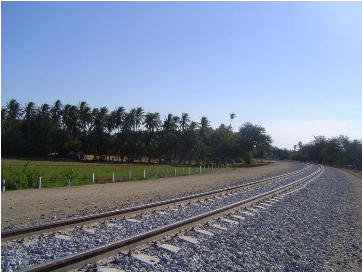
FIT. Libramiento de Tehuantepec
