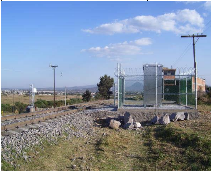
FERROSUR. Sistema de Identificación Automática de Equipo AEI
