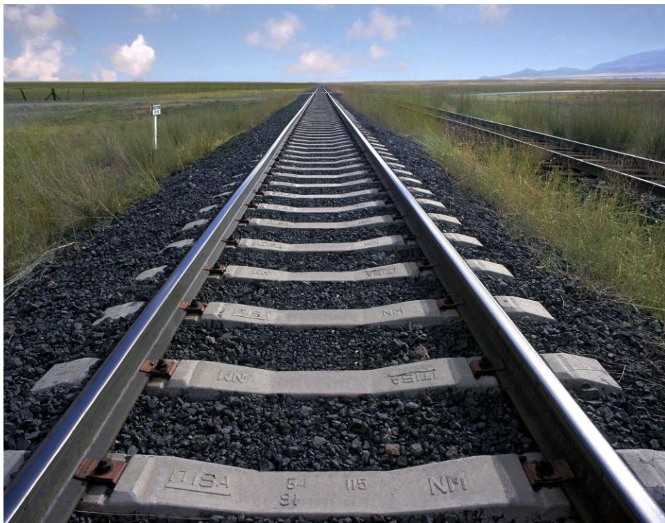
FERROMEX. Rehabilitación de vías
