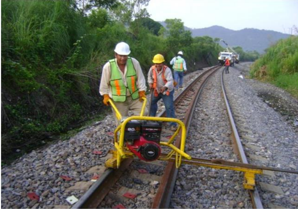
FERROSUR. Trabajos de mantenimiento de vías.
