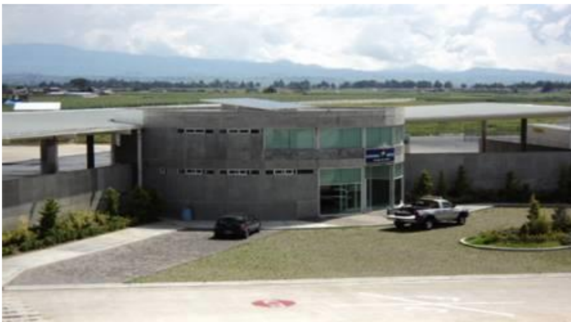
KCSM. Puerta México en Toluca, Estado de México.
