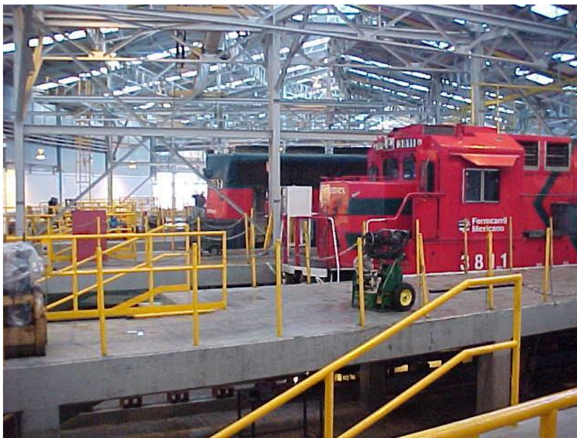
FERROMEX. Rehabilitación del taller locomotoras Guadalajara
