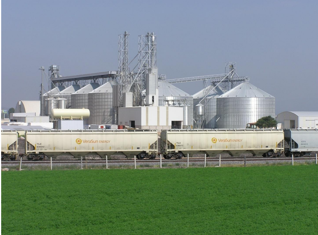
KCSM. Ferroservicios Graneleros Montes en Querétaro.
