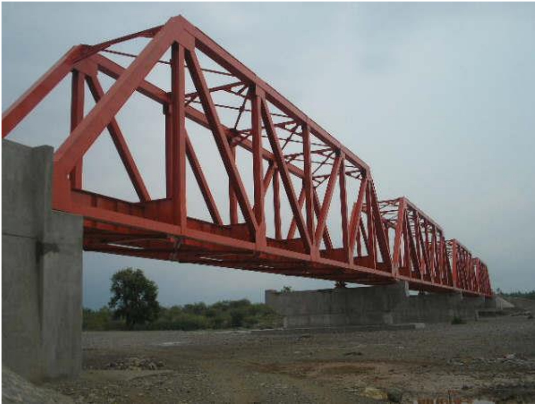
FIT. Libramiento Tehuantepec
