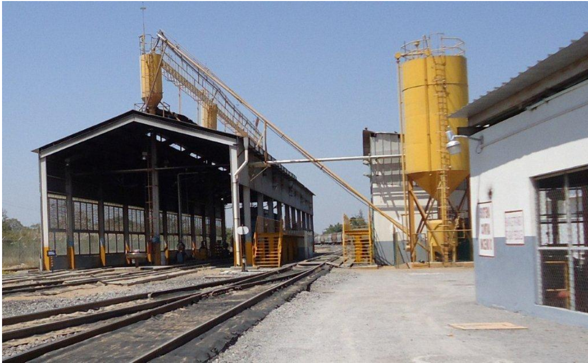
FERROSUR. Construcción zona abastos Tierra Blanca, Ver.
