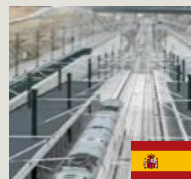
Safety Adif ASFA-Digital en vía para safety ferroviario
