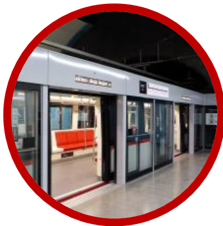
Puertas de Andén
