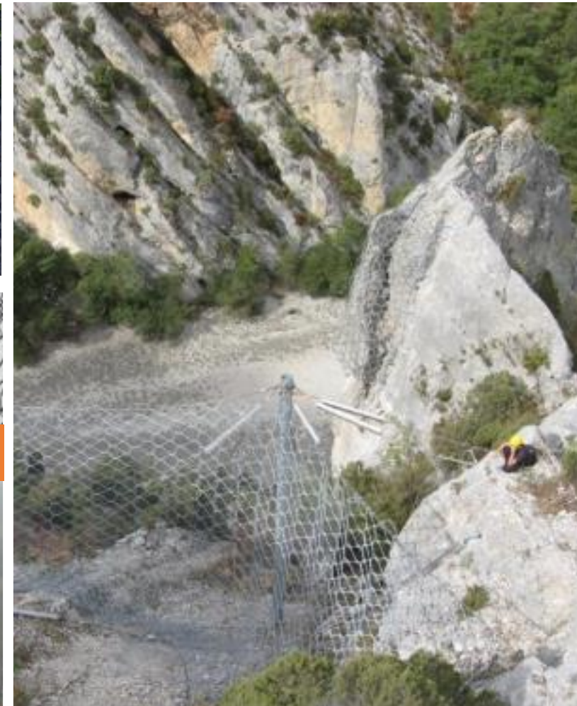
Anclaje lateral en roca
