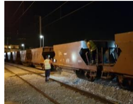
Descarga de Balasto y Perfilado
