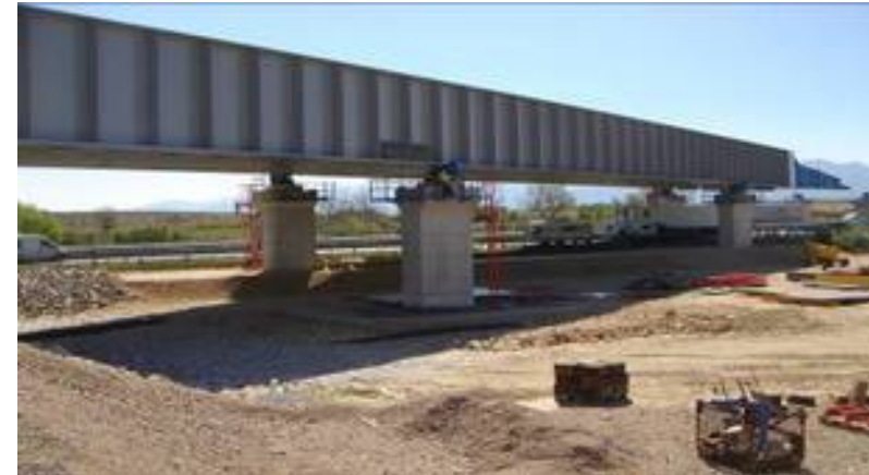
Viaducto sobre la autopista A9
